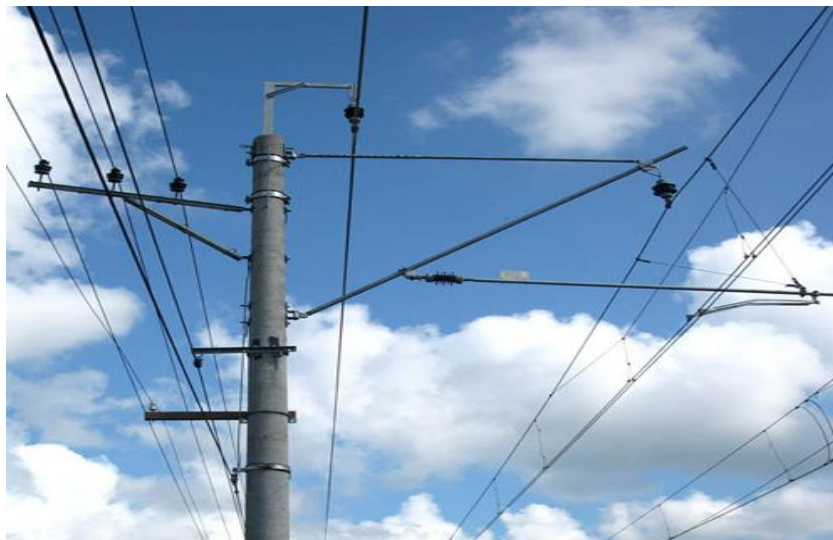
Рисунок 1 – Контактная подвеска КС-160
