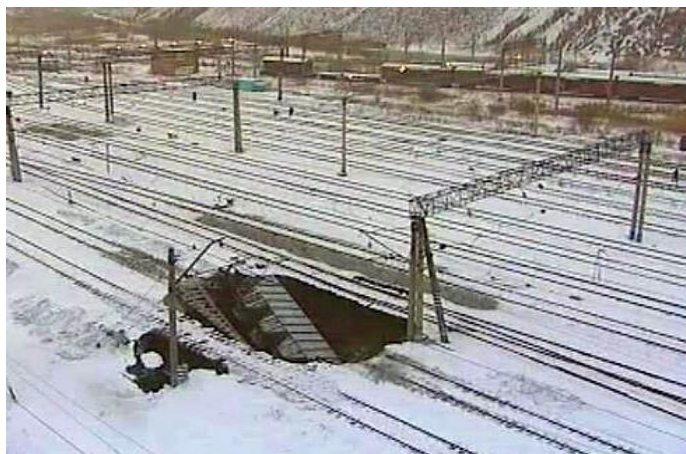
Рисунок 1 – Карстовая деформация на участке железных дорог
